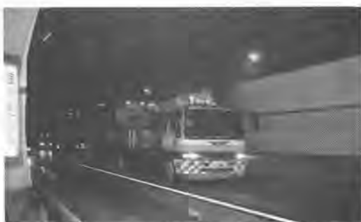
写真-1 トンネル清掃車施工状況
