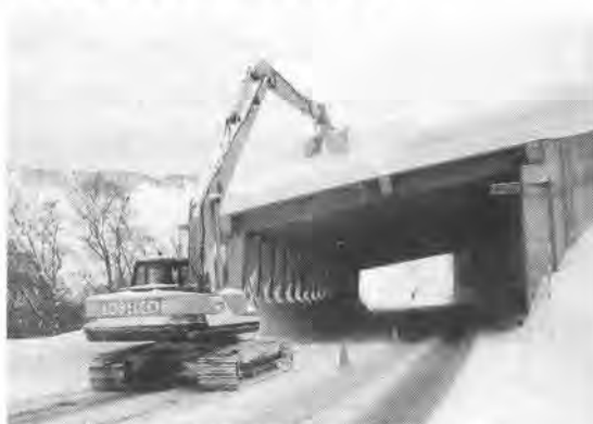
写真-4 スノーシェッド開発機械処理状況
