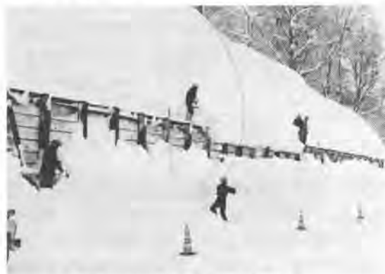
写真-1 防護擁壁柵処理状況
