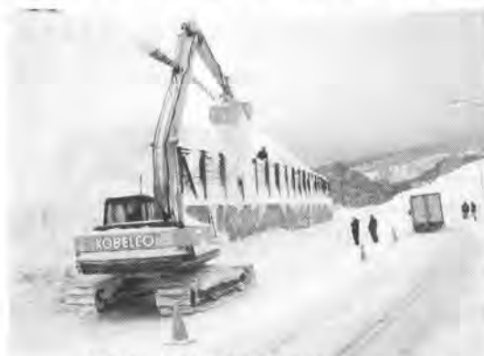
写真-3 防護擁壁開発機械処理状況
