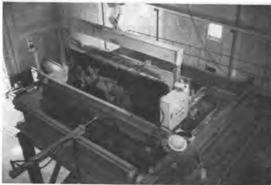
写真-4 掘削残土投入状況
