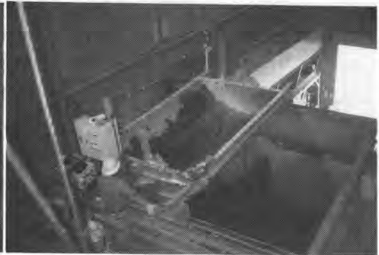
写真-5 攪拌改良状況
