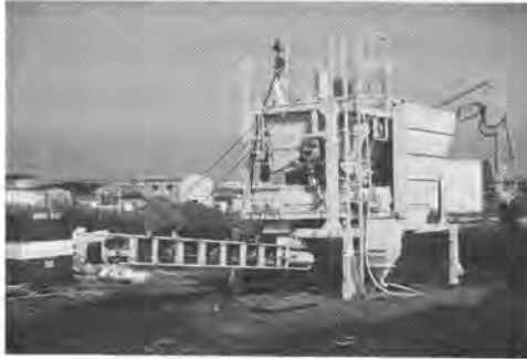
写真1 プラント全景
