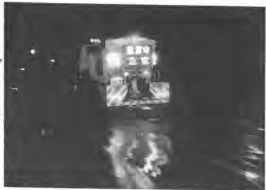
写真-3 作業時の状況
