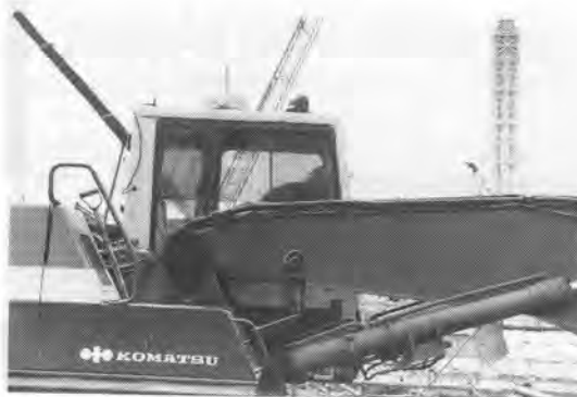
写真-3 バックホーでの実証試験 (横浜火力建設現場にて)
