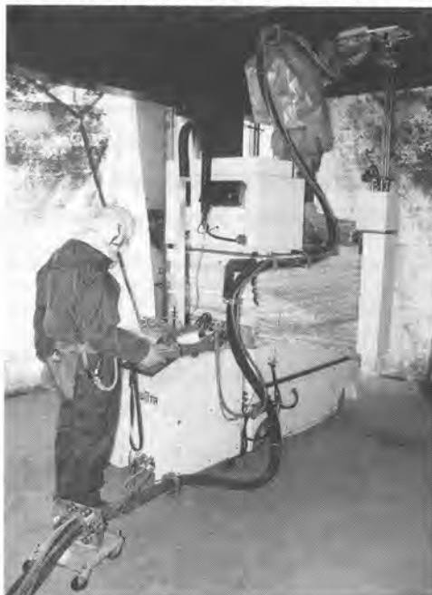
写真-3 作業条件入力状況
