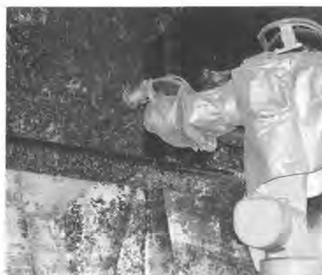
写真-5 吹付け状況
