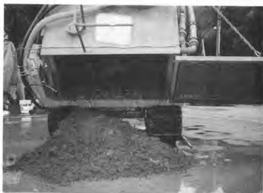
写真-2 ずり排出状況
