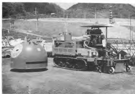
写真-3 ずり回収装置と グリーンカットロボット
