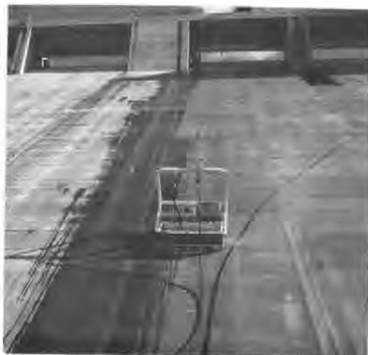
写真-3 施工状況
