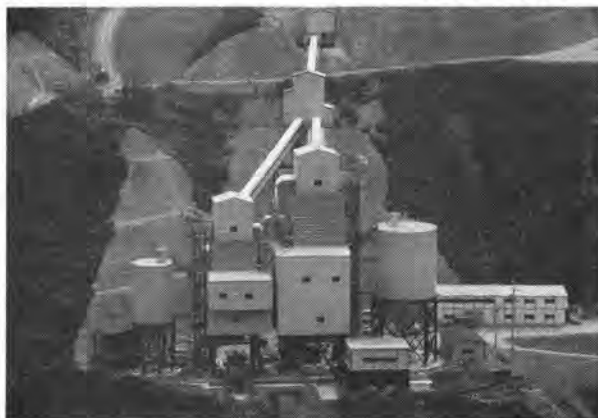
写真-2 コンクリートプラント全景
