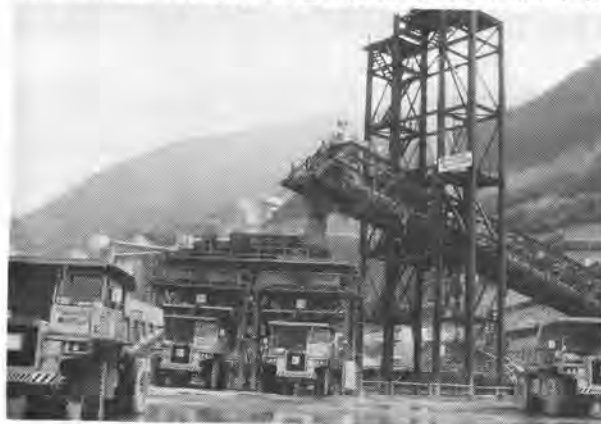
写真-4 シフトアップコンベヤ
