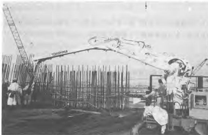
図-6 実施工状況写真
