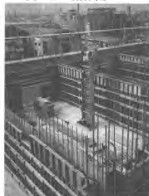
写真-2 装置設置状況
