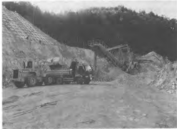
写真-1 クローラクラッシャの稼働状況
