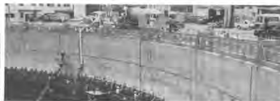
写真一八 打設を完了した外周壁
