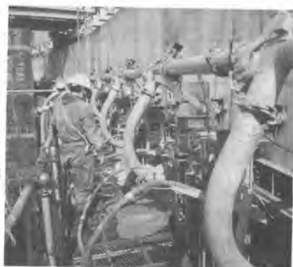
写真-3 打設状況
