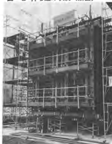
写真-2 モックアップテスト供試体
