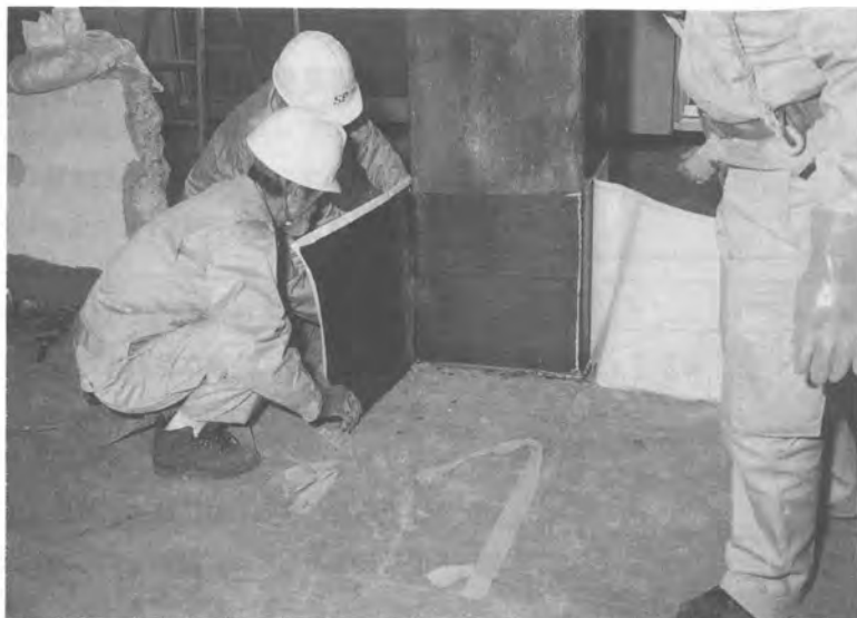
写真5 校舎RC柱へのCFシート横方向巻付け
