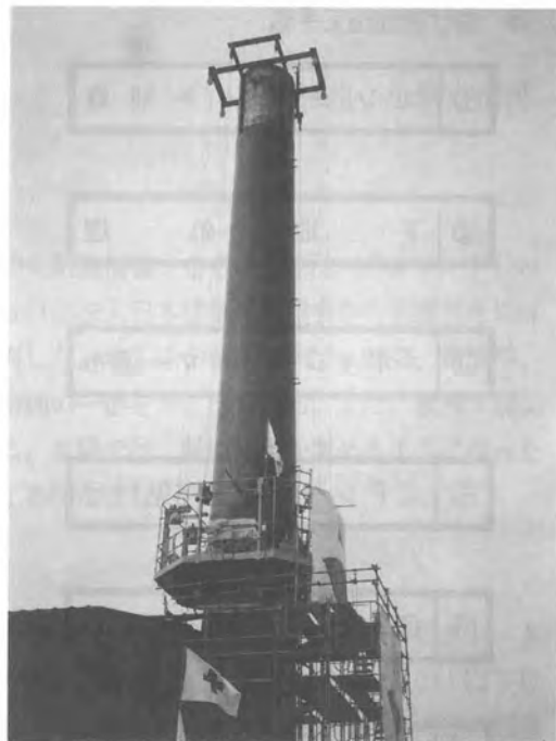
写真2 同CFシート縦方向貼付け
