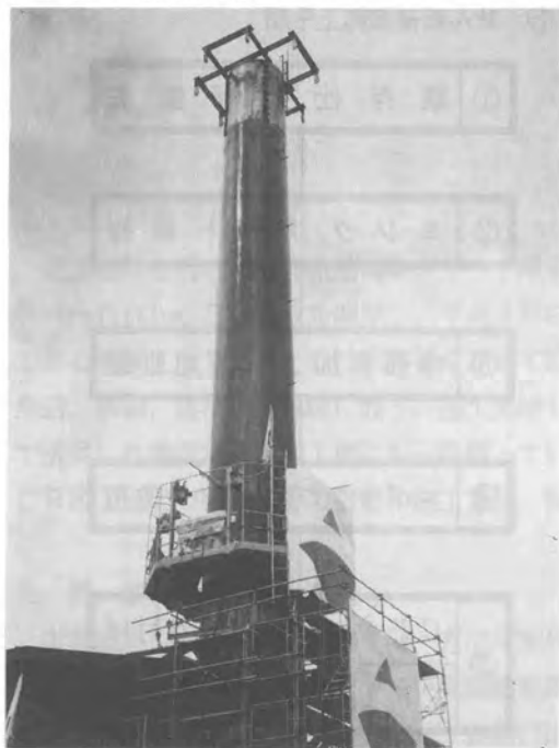
写真1 RC煙突へのプライマー塗布
