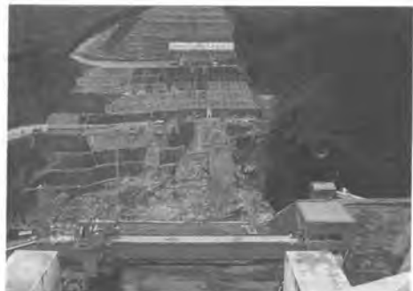
ケーブルクレーン全景
