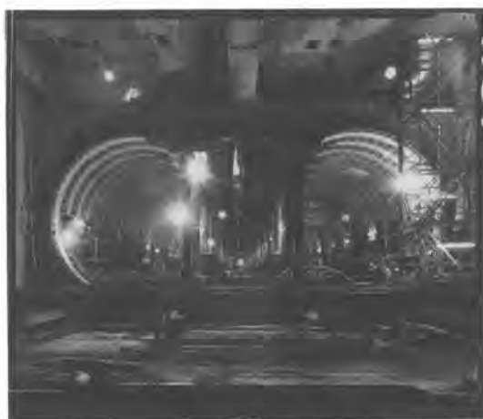
写真-1 シールドトンネル全景
