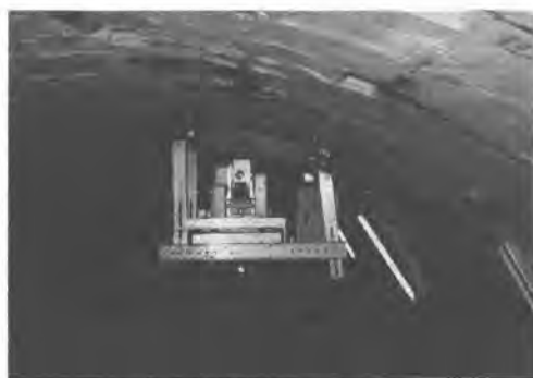
写真-3 トータルステーション取付状況
