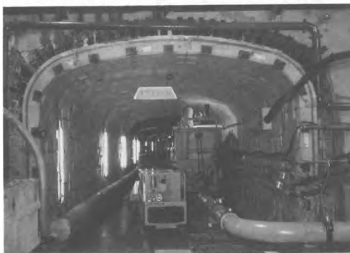
写真-2 発進坑口
