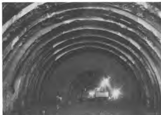
写真-3 施工後の状況
