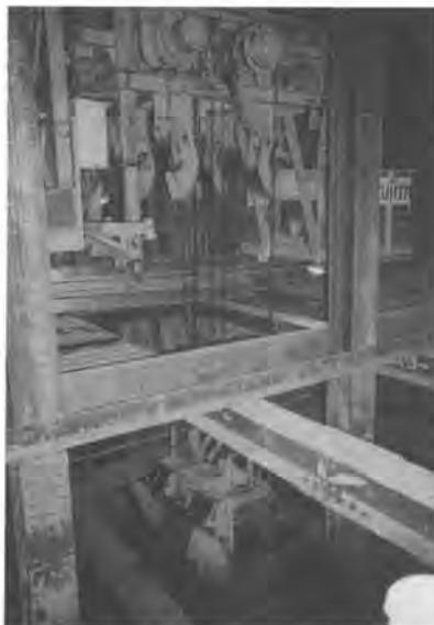
写真-3 自動走行グラブバケット 運転状況(土掘り)
