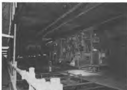
写真-1 坑内運転状況
