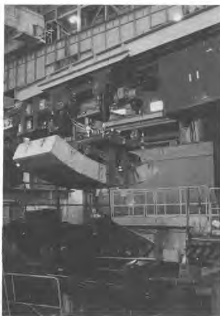
写真2 総合実証実験状況
