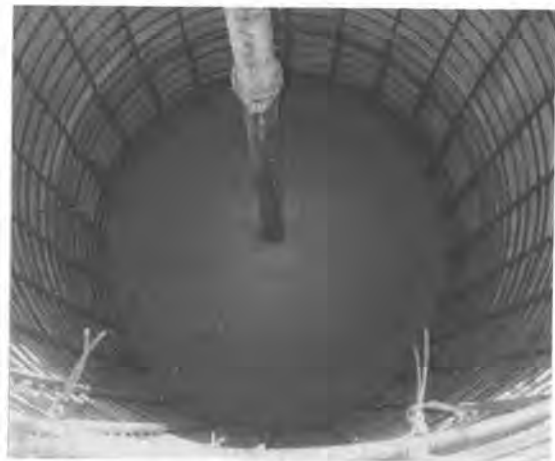
写真-7 コンクリートの打ち込み状況
