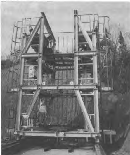
写真-6 鉄筋かごの組立・吊り下ろし状況
