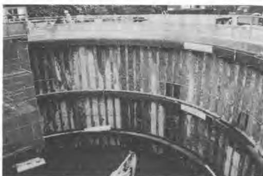
写真-5 名古屋/S現場
