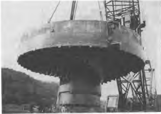
写真-1 拡張掘削装置全景
