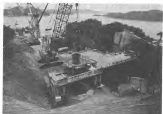
写真-2 スーパーRD工法施工状況
