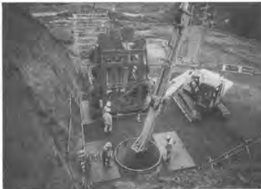
写真-3 弁慶とテレスコラムとの組み合わせ掘削
