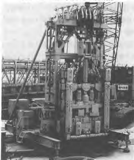
写真-3 BW掘削機用機体位置制御システム
