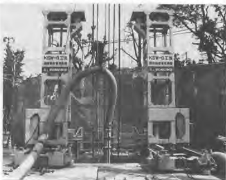
写真-2 施工状況 (EM掘削機)
