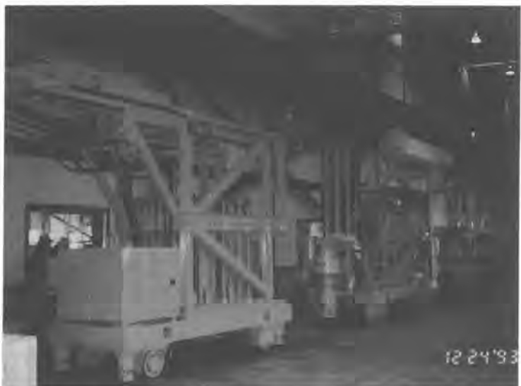
写-1 ロッド台車・掘削機・鋼材運搬台車
