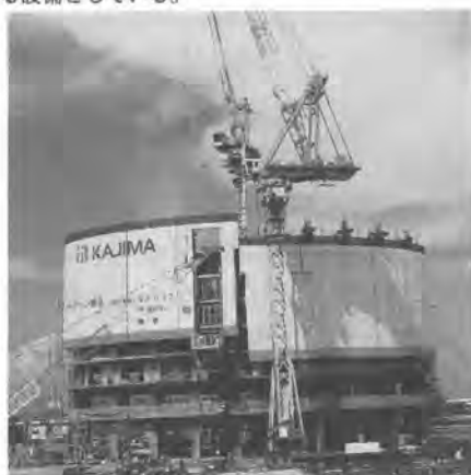
写真-2 自昇式外部養生設備
