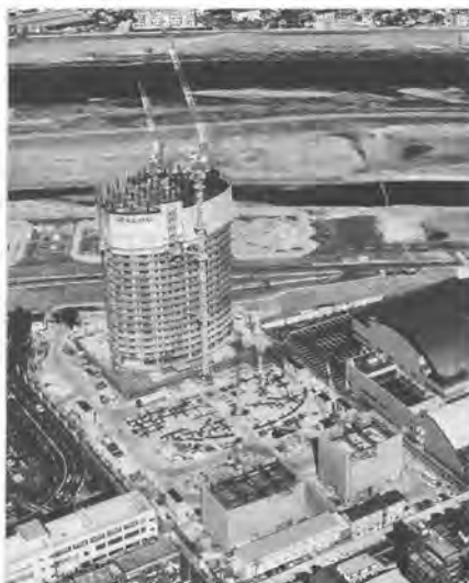
写真-1 ザ・シーン城北工事全景
