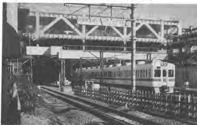
写真-1 トラベリング全景
