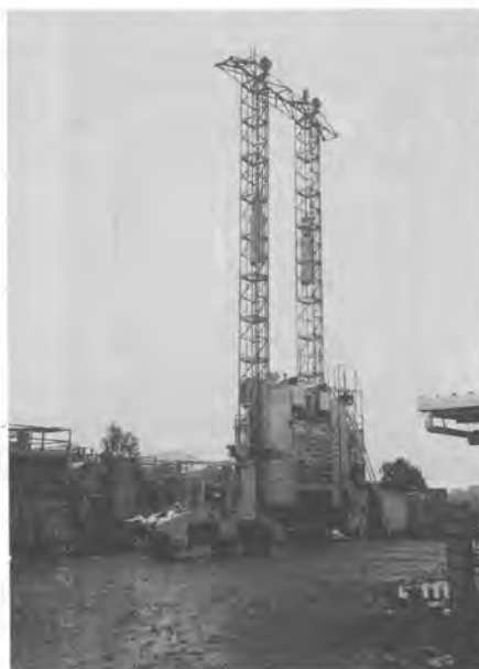
写真-3 Walco Elevators Pty Ltd. 工場試験塔
