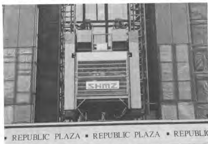
写真-7 4tエレベータ作業員輸送状況
