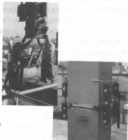
写真-6、7 取付と建入れ状況
