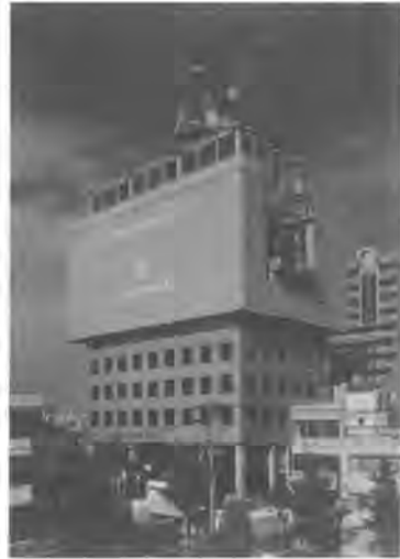
写真-1 施工時外観
