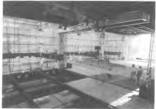
写真-4 作業状況
