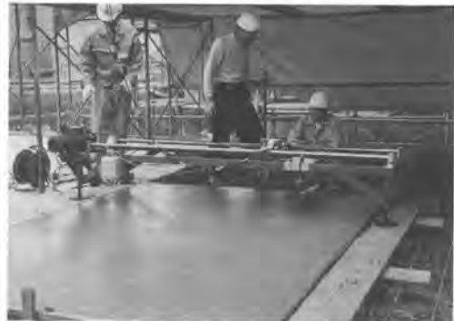
写真-1 こて試験状況
