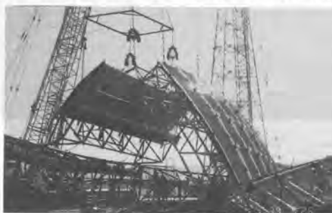
写-3 トラス建方(1)
