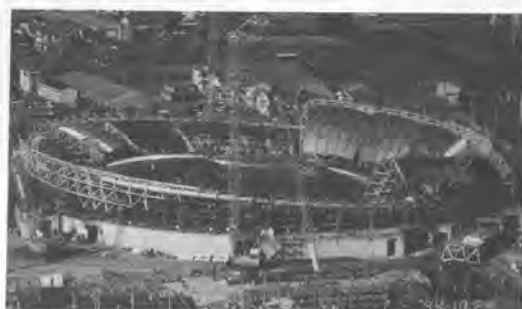
写-4 トラス建方(2)
