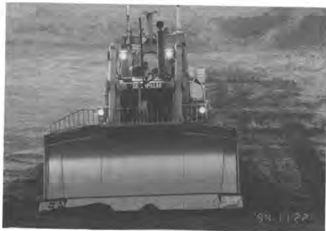
写真一3 施工状況写真
