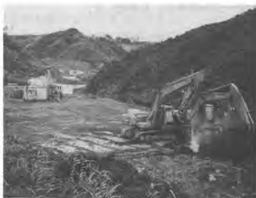
写真-1 施工状況(全景)
