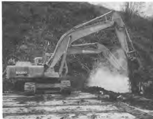
写真-2 施工状況(近景)
