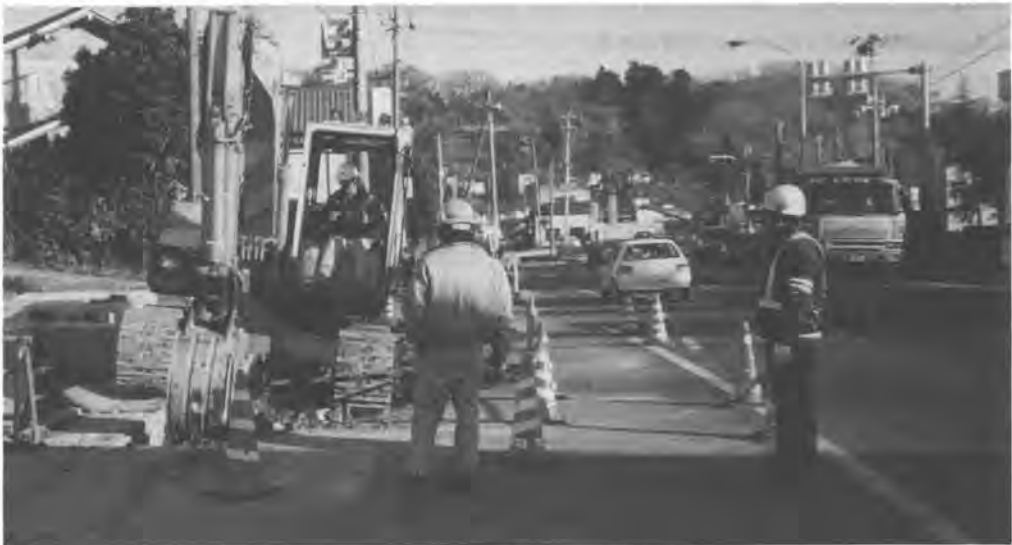
写真2 現場適応性試験状況
