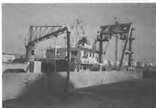
写真-3 バージ積込み状況
