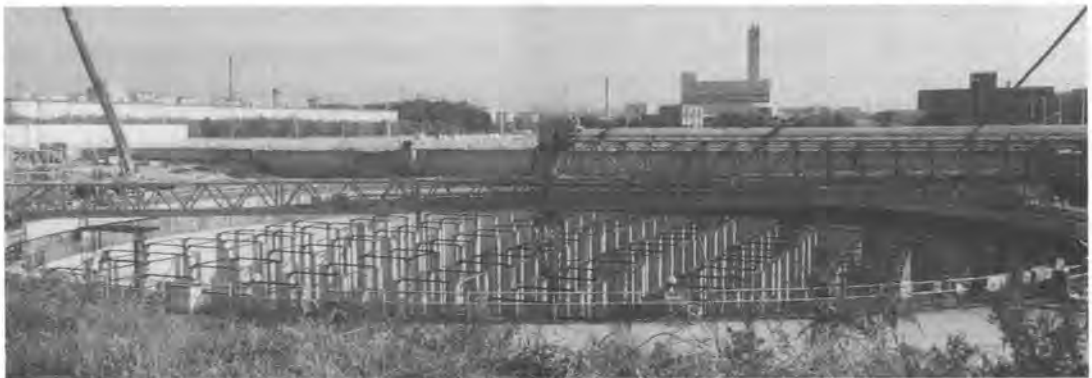
写真一2 全体状況
