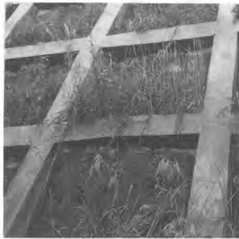
写真3 従来の吹付け施工による緑化
