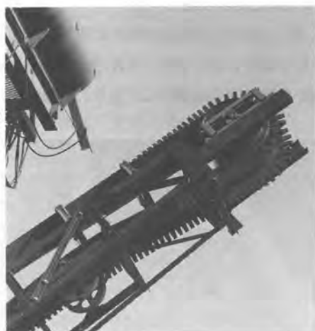
写真4-1 急傾斜ベルトコンベアの先端部
