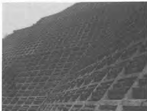
写真1 ポット苗施工による緑化工後の法面
