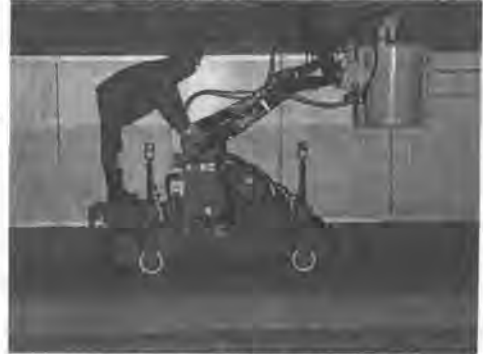
写真-2 試作機現場清掃状況
