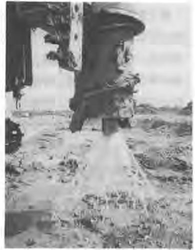
写真-3 水を噴射している状況
