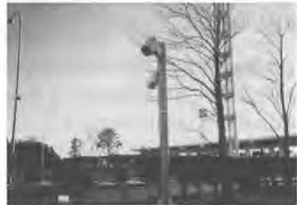
写真-1 フィールド実験場付近と装置外観 (日本道路公団 那須インター)
