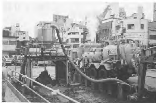
写真-3 吸引排土装置
