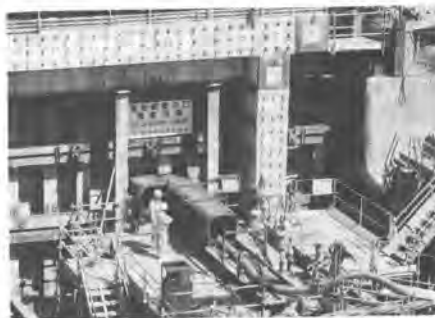
写真-5 現場施工試験状況
