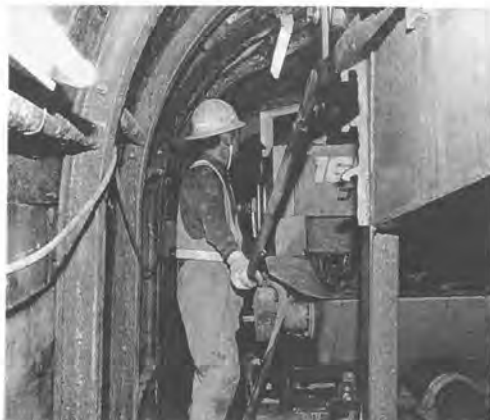
写真4 コンクリートポンプ操作状況
