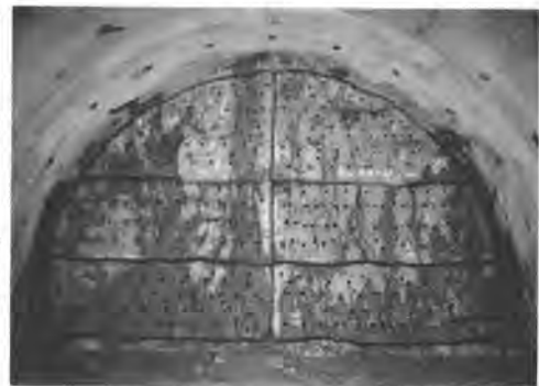
写真-1 連続孔、割岩孔穿孔完了
