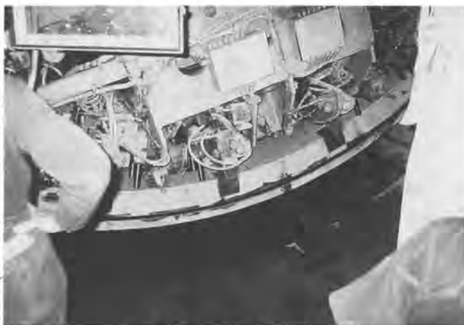
写真-1 Aセグメント組立状況
