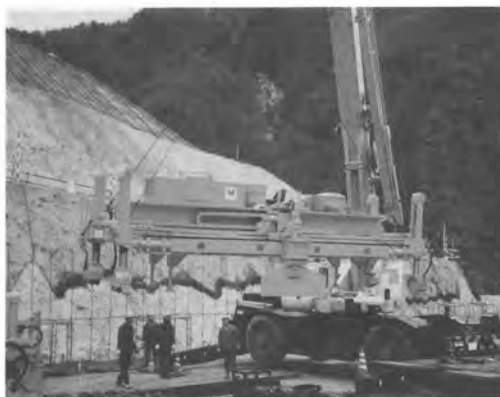
写真-5 コンクリートスプレッダ搬入
