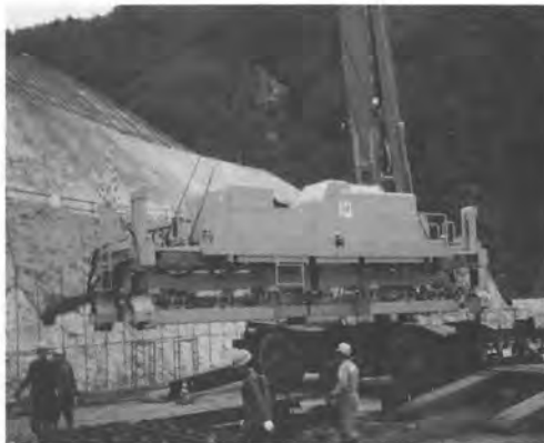
写真-6 コンクリートフィニッシャ搬入
