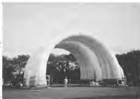
写真-1 パラガスCの全景
