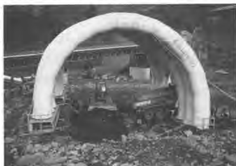
写真－7 現場実験状況
