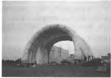
写真-5 設置完了
