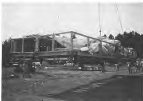
写真-2 連結した4台車の吊り上げ
